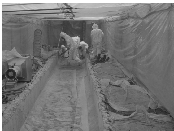
共同溝下部の撤去（汚染閉じ込め部）
