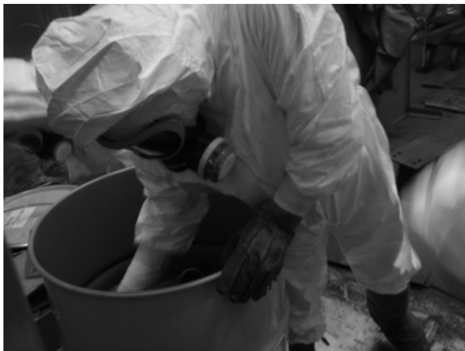
図 4.4.2-6 切断片をドラム缶へ収納
