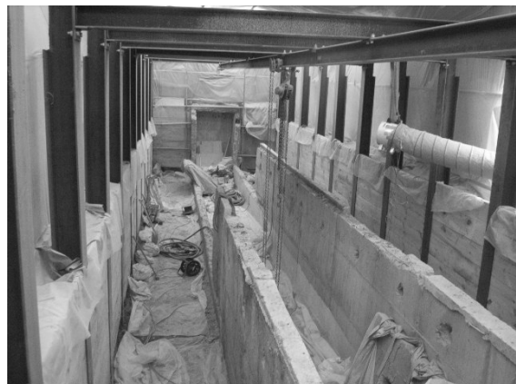
共同溝上部の撤去（放射性廃棄物でない廃棄物）
