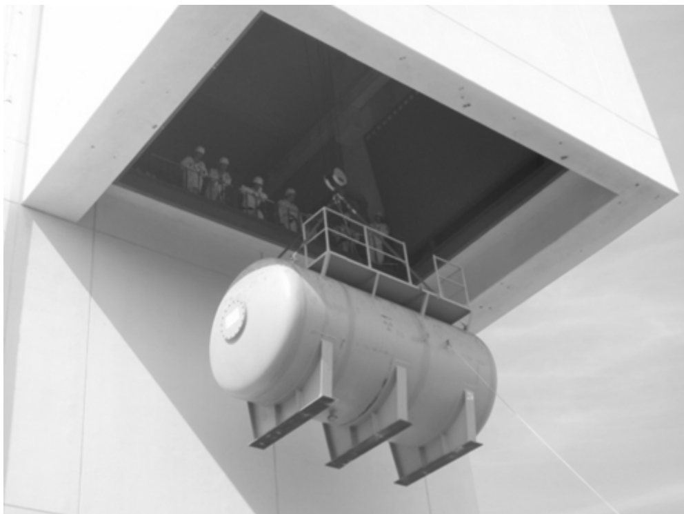
図 4.4.2-1 大型廃棄物を解体分別保管棟へ搬入
