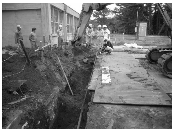
共同溝周辺の土壌掘削
