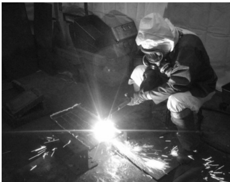
図 4.4.2-4 プラズマ切断機による解体
