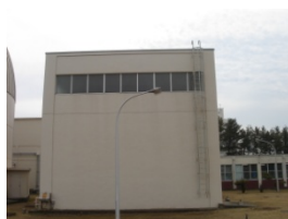
保障措置技術開発 試験室施設 (SGL)
