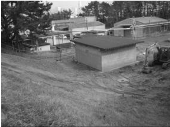
中継ポンプ室西側法面
