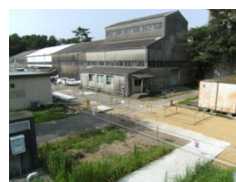
モックアップ試験室建家
