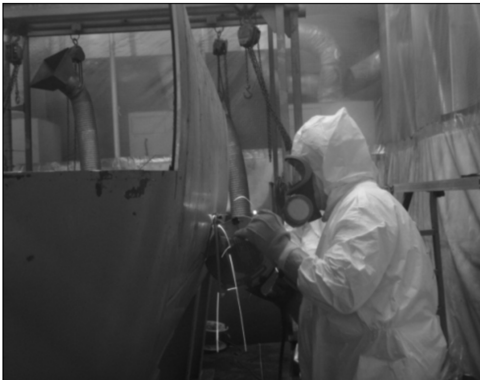
図 4.4.2-3 廃液タンクをチップソーで切断
