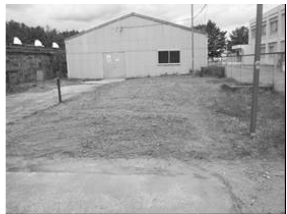
液体処理場東側
