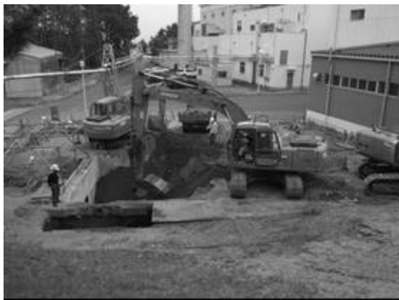
地下部の解体
