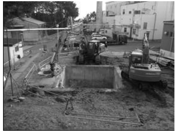
地上部の解体
