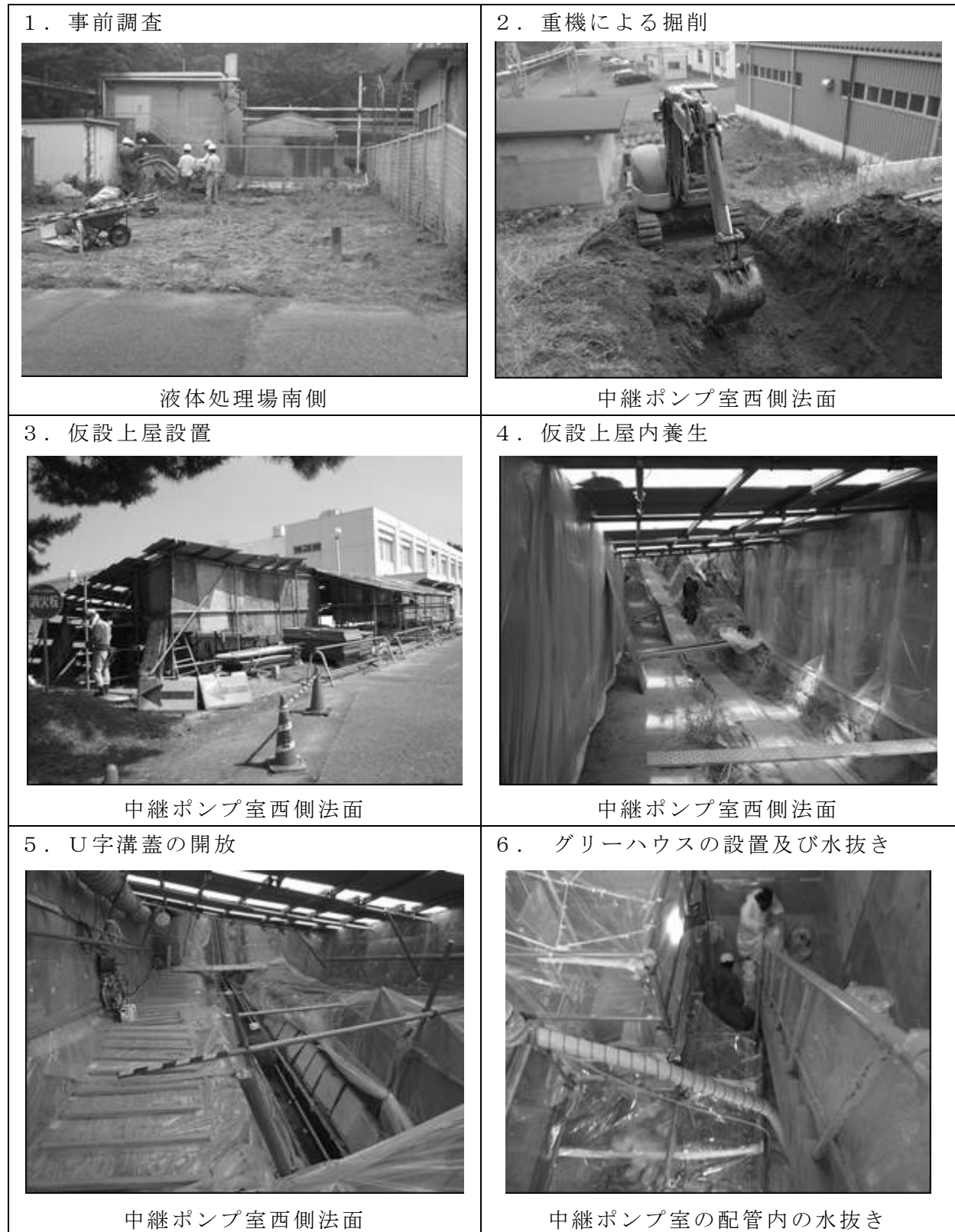
図 10.4.1-2 廃液輸送管撤去の各工程の作業状況(1/3)
