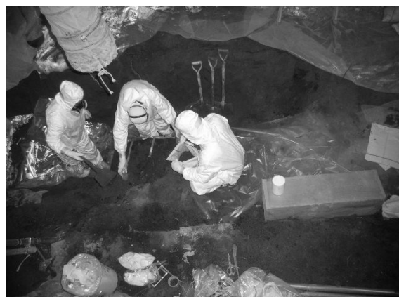
汚染土壌の撤去
