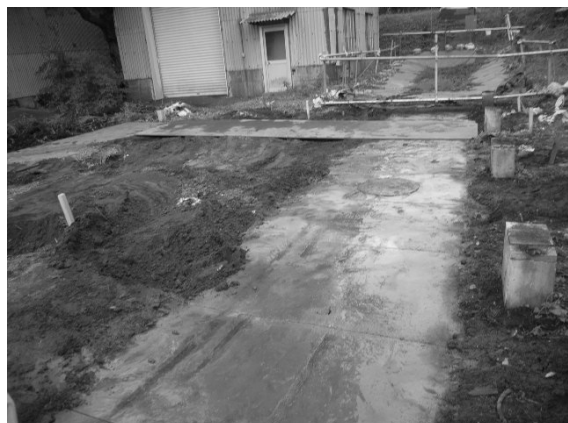
東西方向共同溝撤去前
